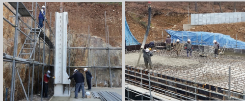
현장시공 40% - 타설, 거치, 조립 및 완성
