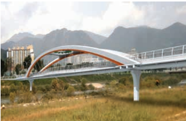
■ 화순 하천 환경정비사업 보도교 설치공사 (2013년) L=107m, B=3.0m / LSP 강관거더
