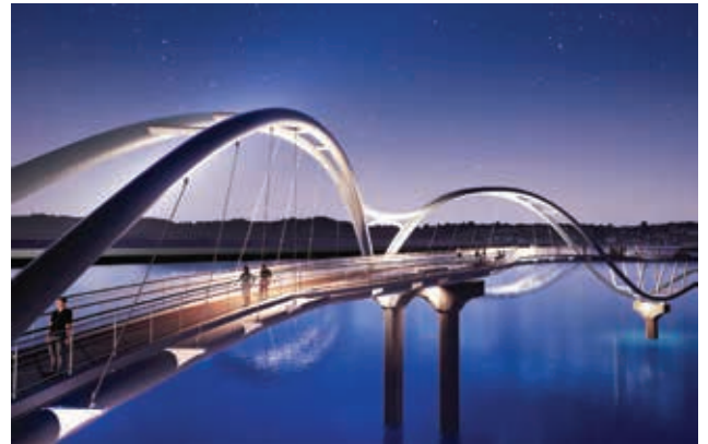
■ 부산 구포역 감동나루길 리버워크 L=280m, B=3.6m / LSP 강관거더 및 강관아치
