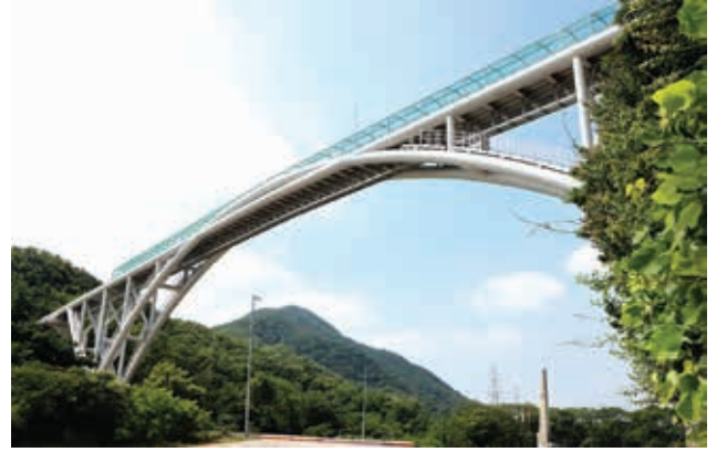
■ 용인 석성산~할미산성 한남정맥 단절 연결보도교 설치공사 (2017년) L=168m, B=3.0m / LSP 강관거더
